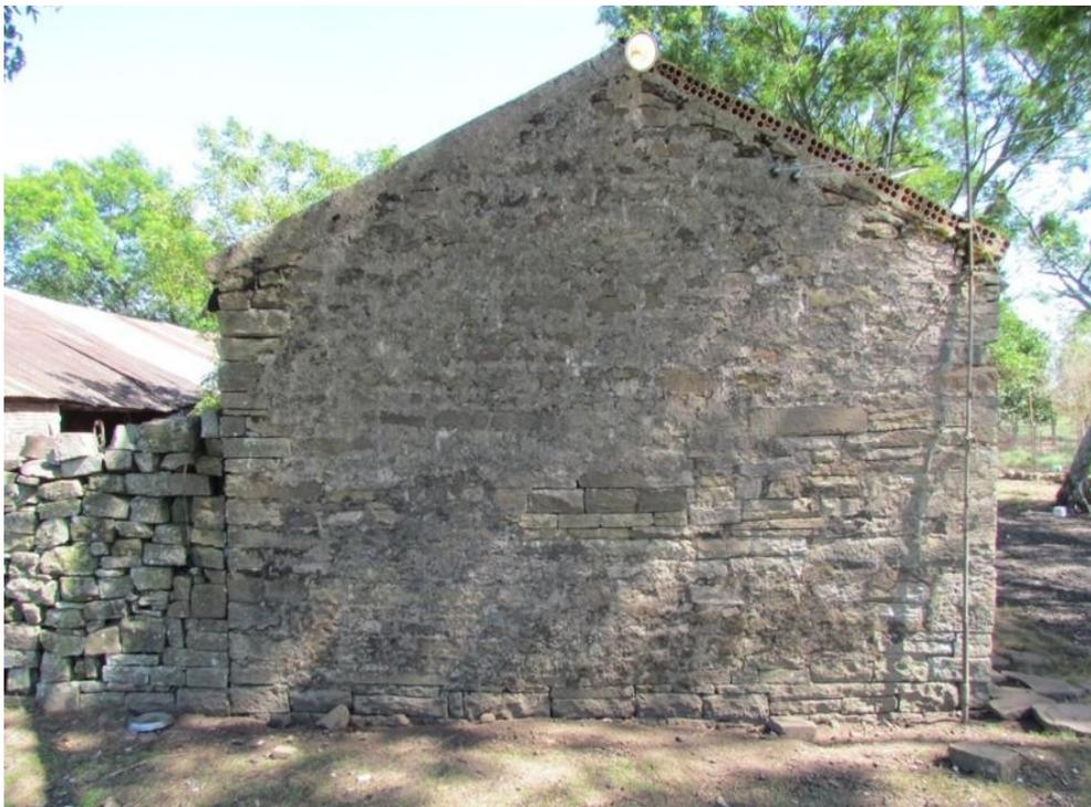
Figura 46. Parede lateral da primeira casa, com cobertura em duas águas desiguais. À esquerda, a taipa que fecha o pátio.
