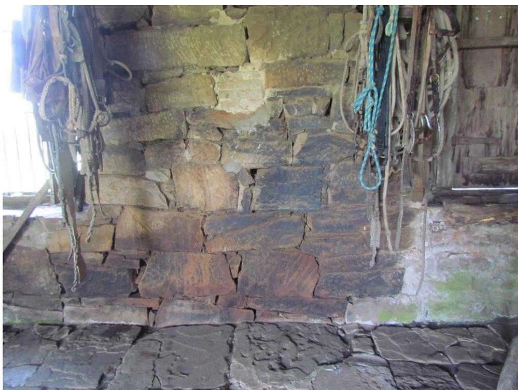
Foto 98. Interior do prédio 1. Paredes e piso de grandes pedras, ligado ao manejo de gado.
