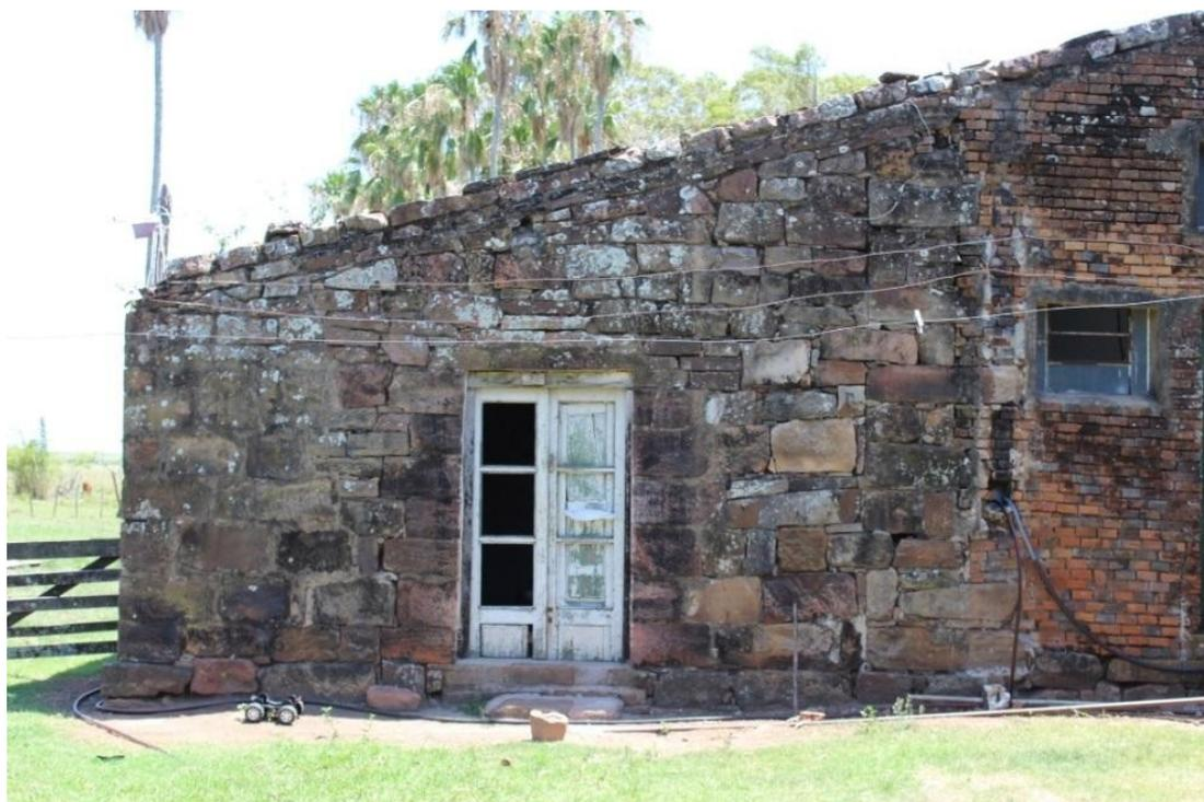
Figura 59 A esquina entre a parede lateral direita e a parede do fundo, vista por fora, em pedra.
