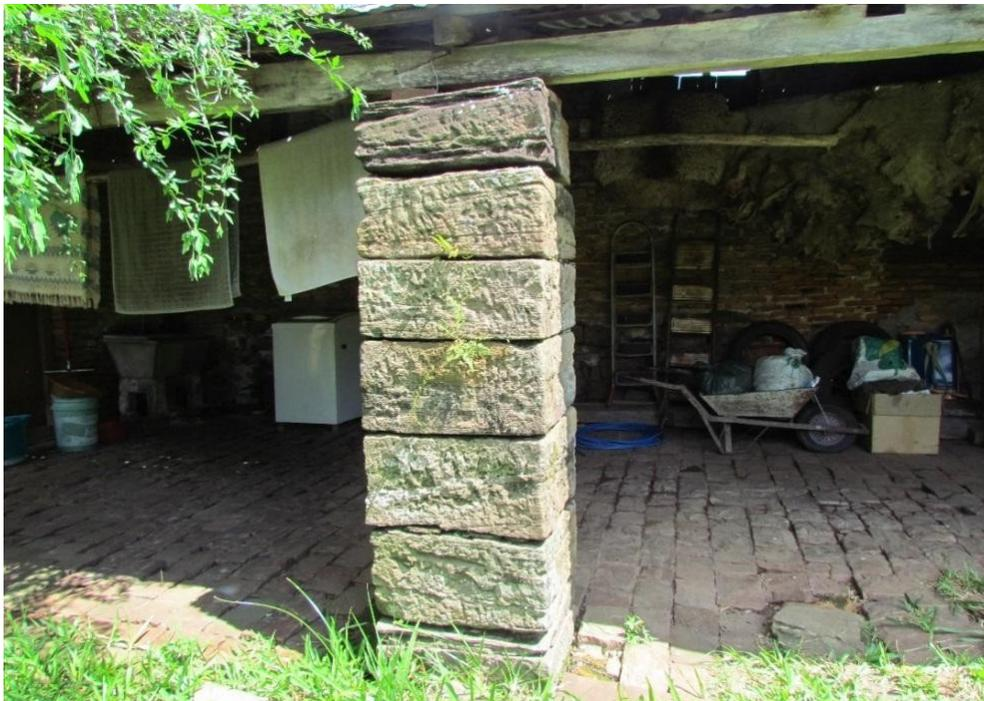
Figura 102. O interior do prédio 2. Coluna de pedra sustentando o telhado, piso de pedras regulares. Lugar de trabalho e depósito.
