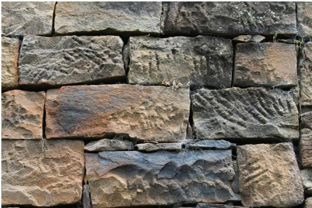
Figura 112. Detalhe da maneira de cantejar e assentar a pedra na parede do lado 3.
