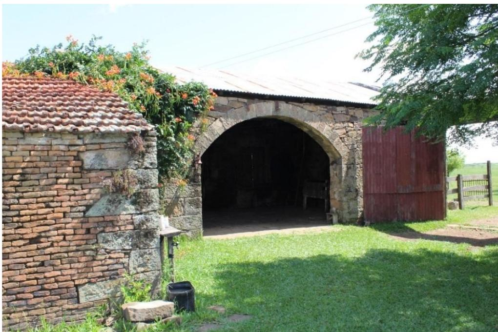
Figura 100. Os dois portões: o da entrada e o do prédio 1. O anexo, à esquerda na foto, mostra a combinação de estruturas de pedra com tijolos.
