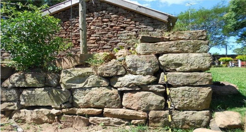
Figura 24. As fundações do acréscimo do lado esquerdo da casa, em blocos maiores canteados., base para paredes de adobe (?)
