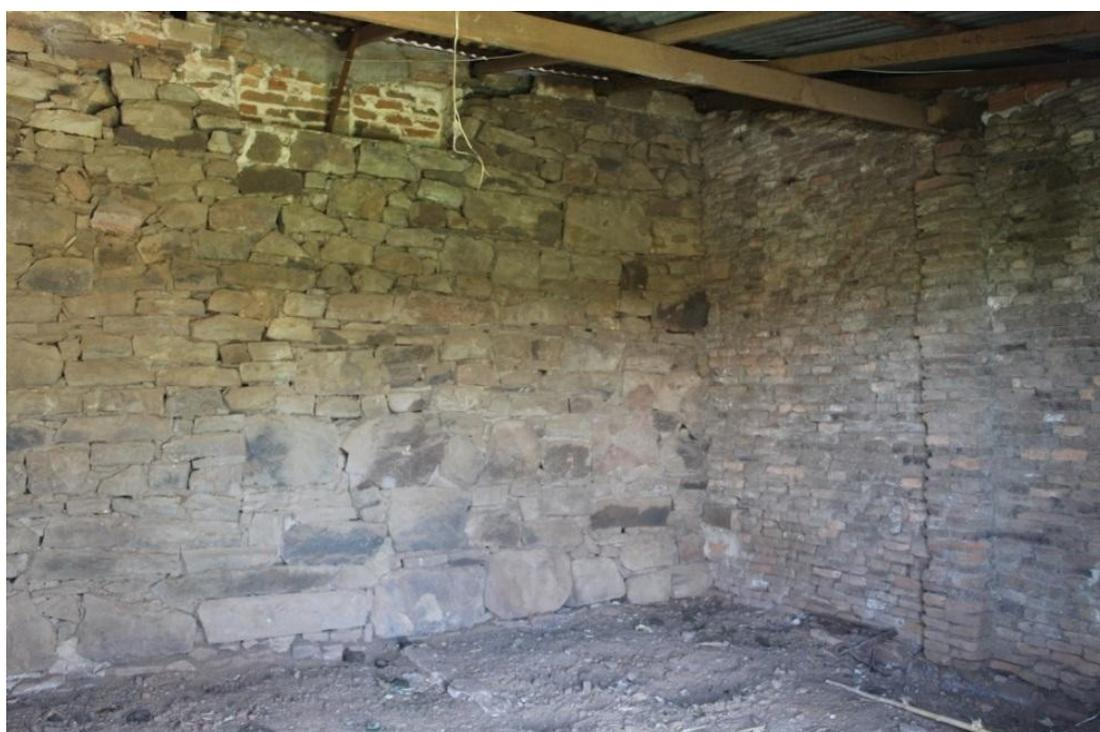
Figura 60. Vista interna da esquina: a parede de pedra original e os acréscimos em tijolo maciço.
