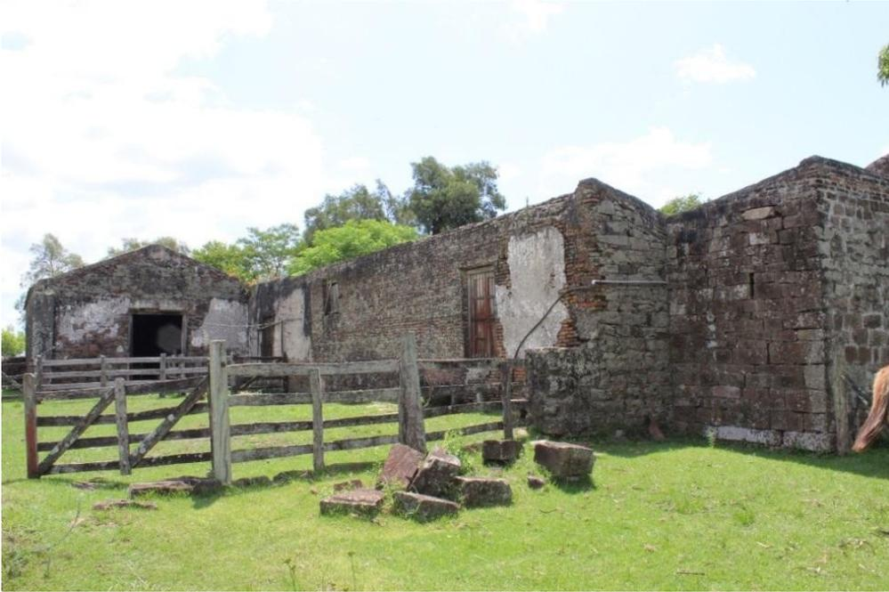
Figura 101. No centro, o prédio 2; à esquerda, o prédio 1; à direita, o canto do prédio 3. Em pedra canteada, com duas janelas para os currais, telhado em uma água para dentro do quadrilátero.
