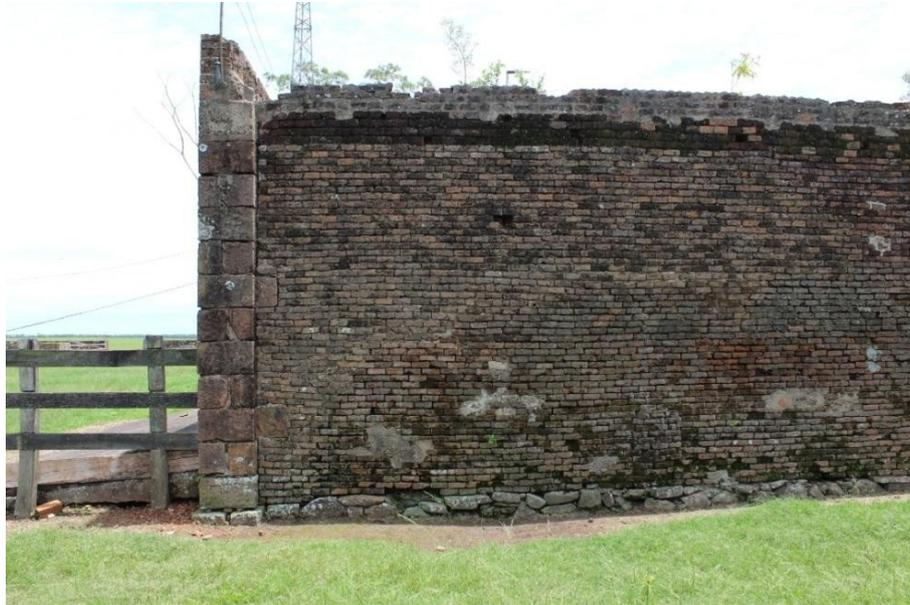
Figura 57. Parede lateral direita mostrando a disjunção entre a fachada de pedra canteada e a parede de tijolos.
