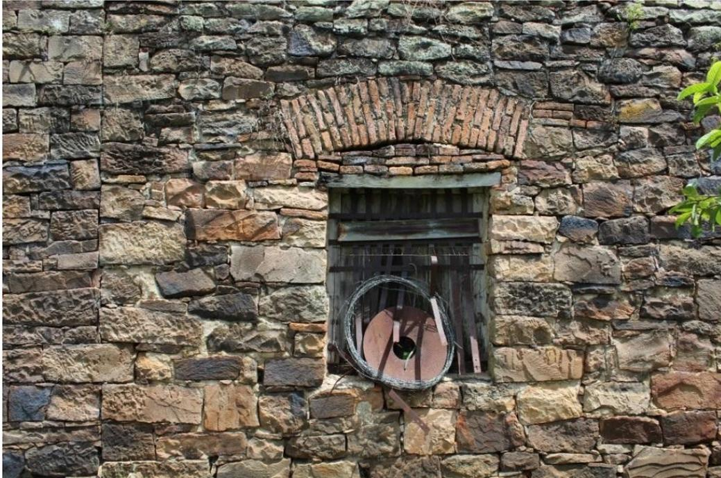
Figura 111. Vista externa de uma janela na parede do lado 3. Observar a maneira de fazer o arco da janela; e a desconexão entre as construções no lado esquerdo.
