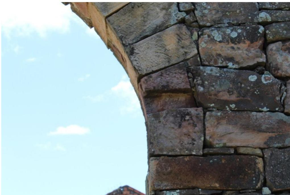
Figura 74. Outro detalhe: um vão para implantação de trave transversal de madeira entre a parede vertical e a curva para dar segurança à parte móvel do portão. Na figura 72 se vê como ela funcionaria; também na figura 111.
