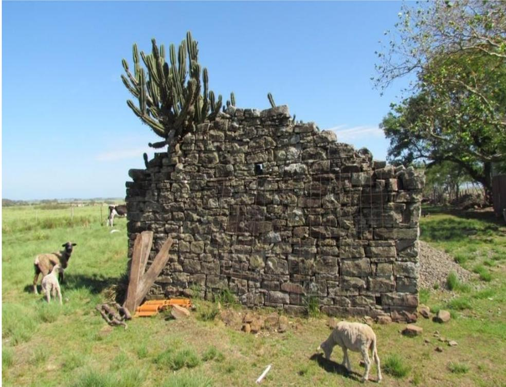
Figura 49. Parede da antiga capela; cobertura em duas águas desiguais.
