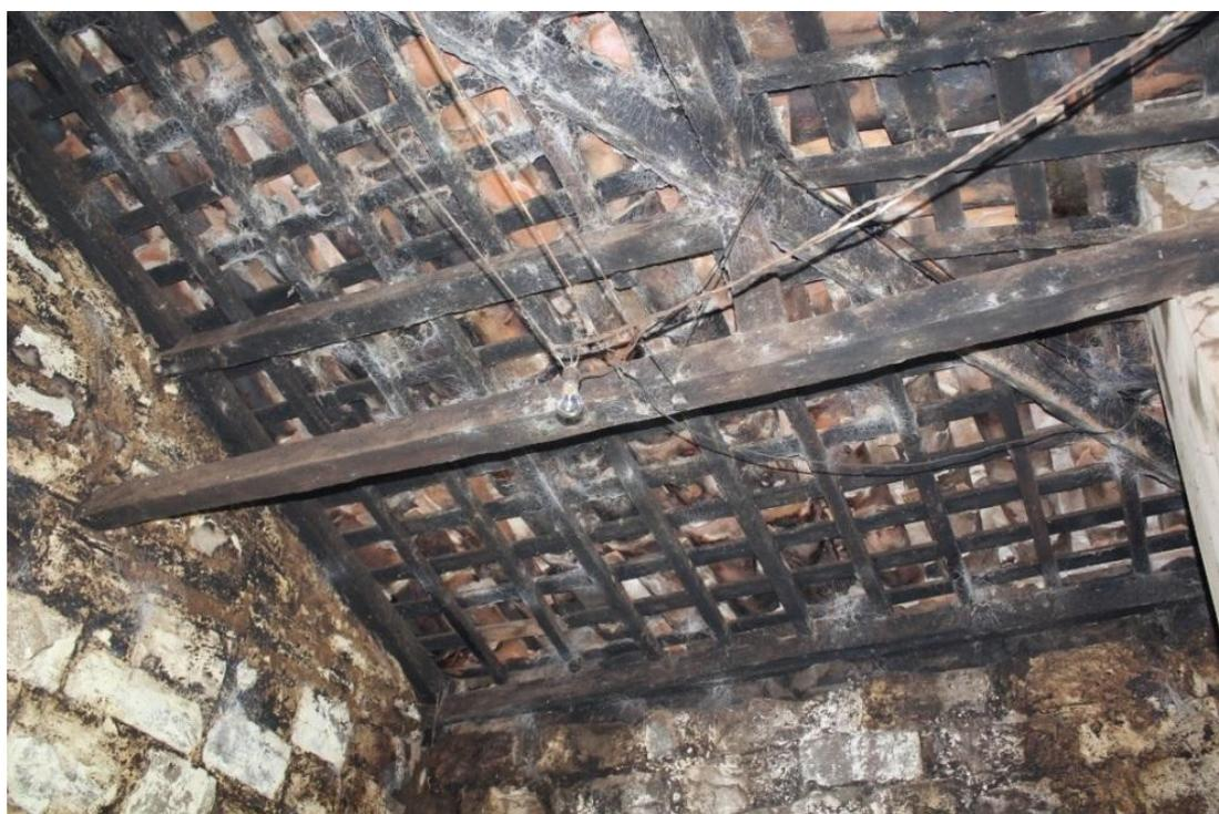
Figura 62 A cobertura de telha canoa numa das construções em pedra.
