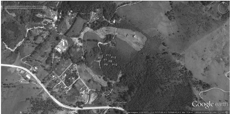
Figura 2. Localização das parcelas na área #2 – Floresta de aprox. 20 anos. No centro da imagem um desabamento de janeiro de 2011. Google Earth, imagem de 19/01/2011. Município de Nova Friburgo, Rio de Janeiro.
